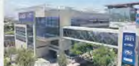
Vista aérea Edificio Ingeniería II, Campus Ventanas.
